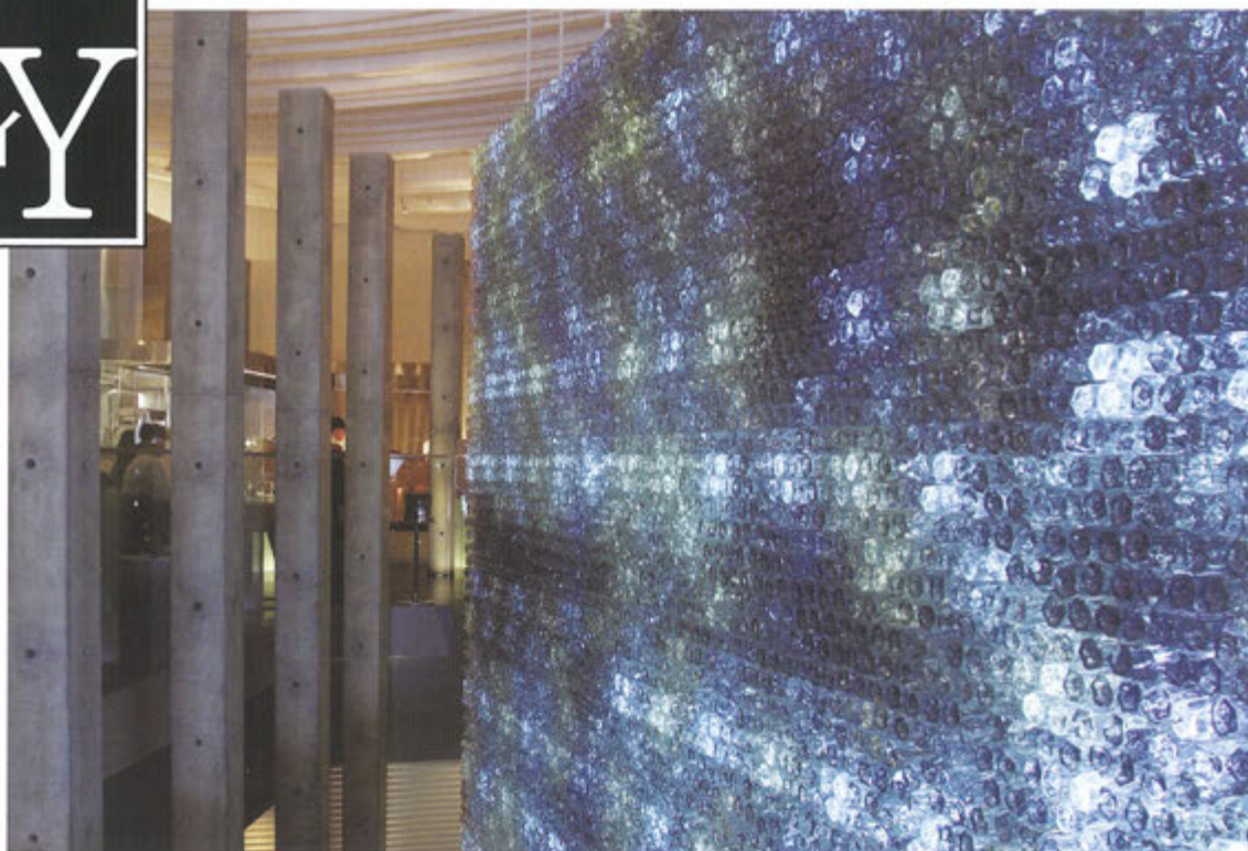
Morimoto New York: 88 10th Avenue New York, NY 10011 安藤忠雄氏デザインのレストラン。17,400個のプラスチックボトルの奥にLEDが光る“Bottle Wall”と、絹のようになめらかな手触りのコンクリート柱。
